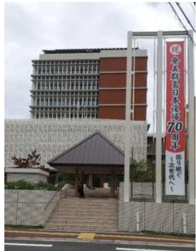
奄美市役所本館
